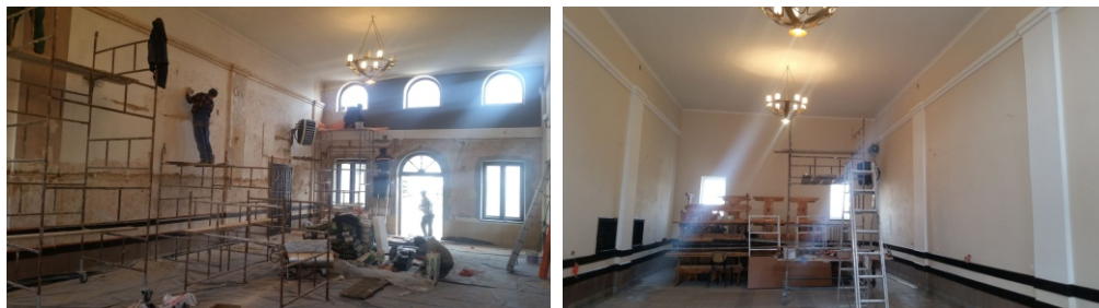
Prace remontowe w budynku domu parafialnego
